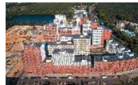
ЖК «Новокрасово», МО «Тройка РЭД»
