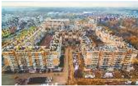
ЖК «Новое Яино», Ленинградская область ГК «ЦДС»
